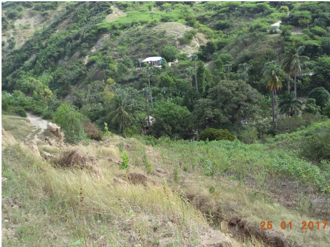
Figure 10: Habitats à risque, se trouvant en aval au pied du versant instable où s'est produit le glissement. Ces gens sont à délocaliser
